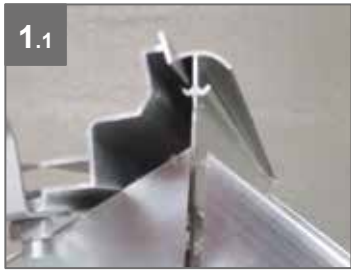
1.1 Pose de la lucarne sur faîtière par glissement
