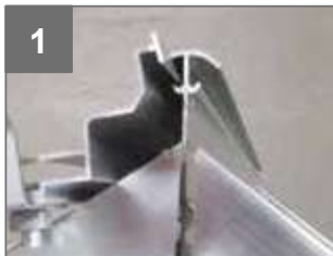
Pose de la lucarne sur faîtière par glissement.
