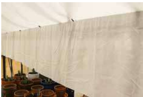
Système d'ombrage Beschattungssystem Shading system
