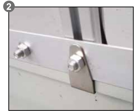
Crochet à positionner Haken anbringen Attach hook
