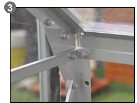
Vue intérieure Innenansicht - Interior view
