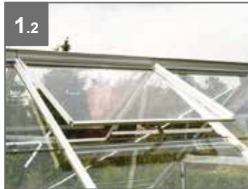
1.2 Lucarne Vue extérieure
